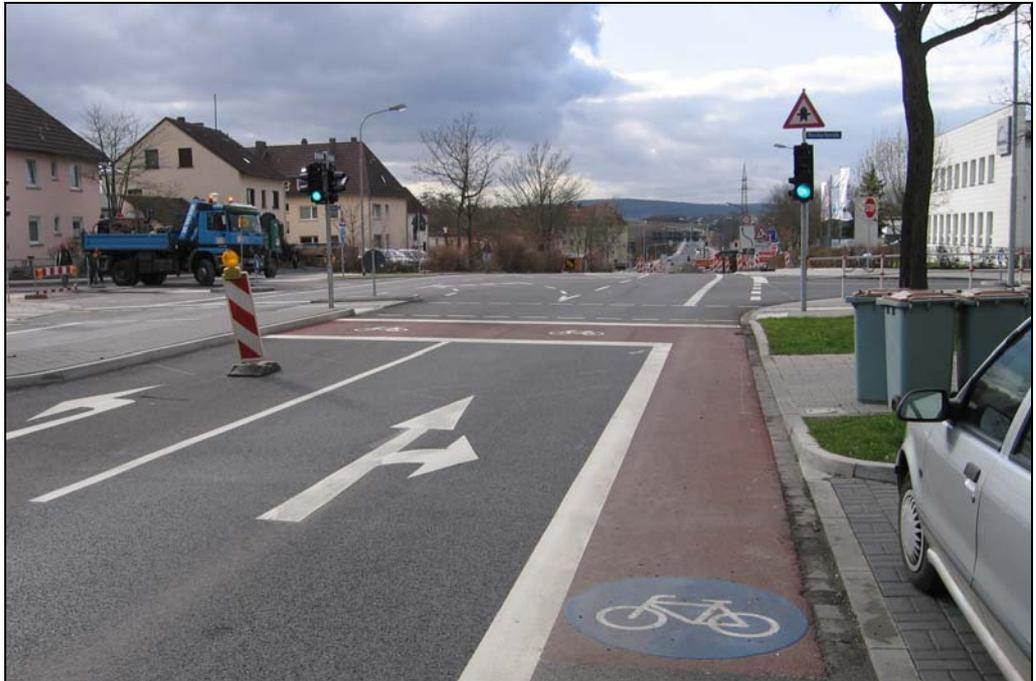
Bild A-5: Radfahrstreifen mit aufgeweiteter Aufstellfläche (Mainstraße)
