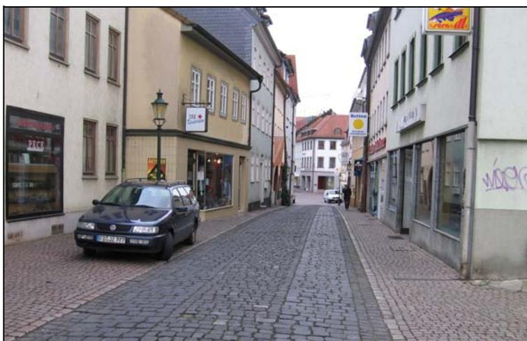
Bild 3-10 Für Radverkehr ungünstiger Belagszustand mit Kopfsteinpflaster (Florengasse)
