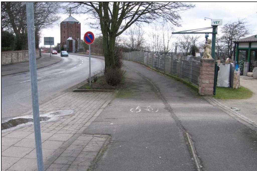
Bild A-23: Mängel an Radverkehrsanlage: Bordversatz zwischen Geh- und Radweg (Heidelsteinstraße)
