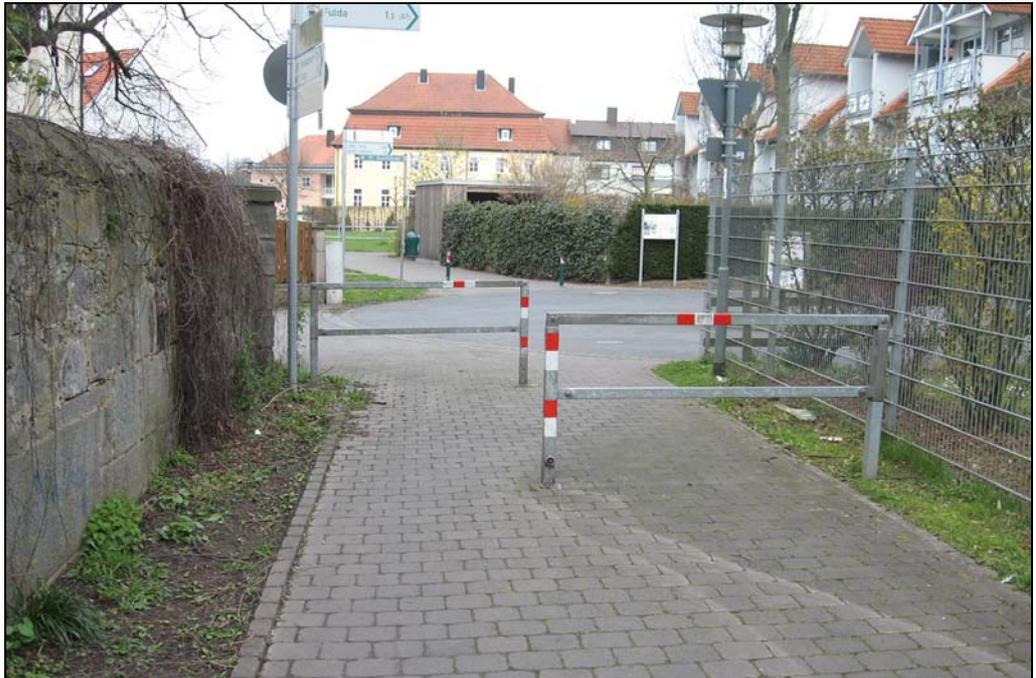
Bild A-18: Umlaufsperre mit ausreichendem Abstand (R1 Höhe Wiesenmühle)
