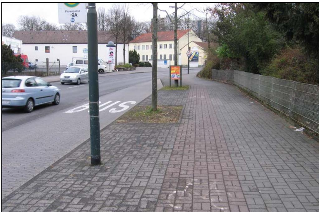
Bild A-24: Radwegbreite unter Mindestanforderungen sowie abgenutzte Markierung (Künzeller Straße)
