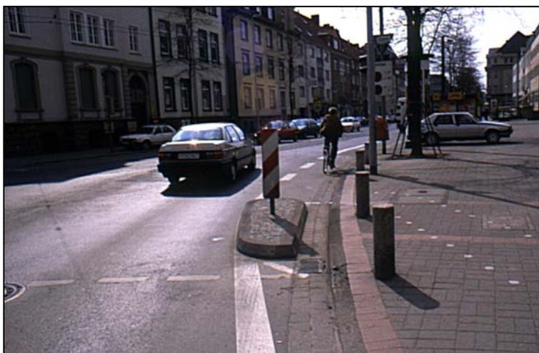
Bild 4-4 Gesichertes Radwegende, in diesem Fall mit Weiterführung als Schutzstreifen (Hannover)
