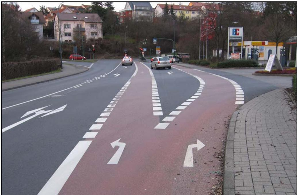
Bild A-6: Abbiegestreifen zum direkten Links- bzw. Rechtsabbiegen (Kreuzbergstraße)
