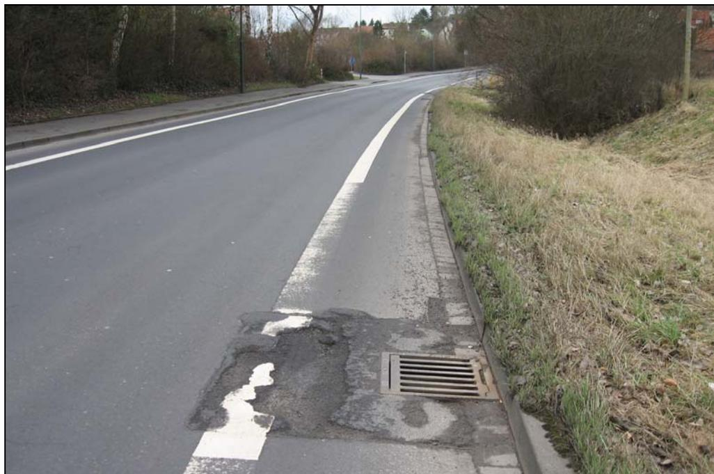
Bild A-30: Belagschäden auf Radfahrsteifen (Mackenrodtstraße)
