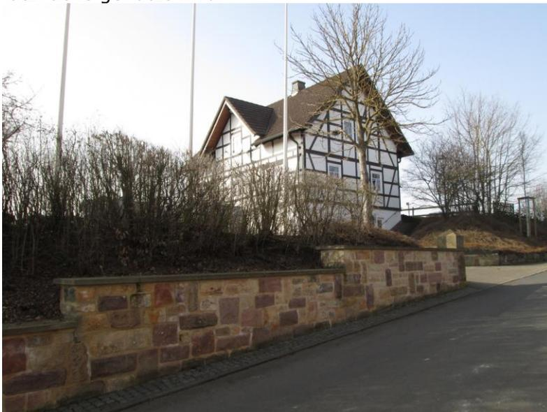
Aufgrund der nach Süden abfallenden Hangneigung wird das Gelände mittels Stützmauer in Verbindung mit einer bewachsenen Böschung bzw. Aufwallung gegenüber dem Straßenraum abgegrenzt.
