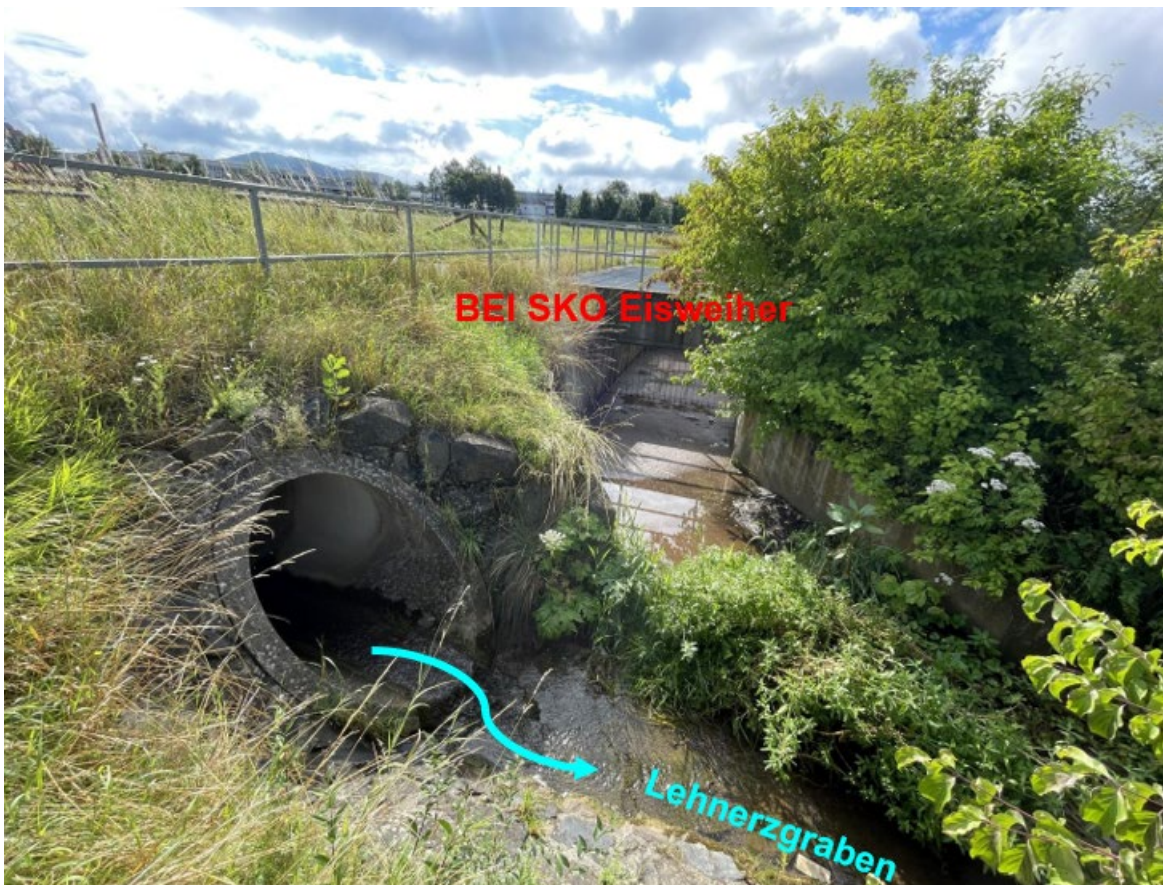
Abbildung 11: Ausmündung Entlastung „BEI SKO Eisweiher“ in „Lehnerzgraben“
