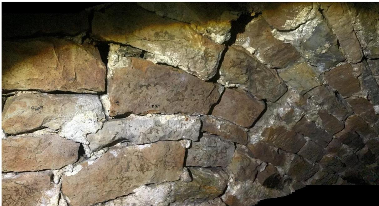
**Abbildung 8: Tiefkeller des Waldschlösschens, teils ausgemauertes Gewölbe, zwischen den Steinen befinden sich zahlreiche Fugen**
