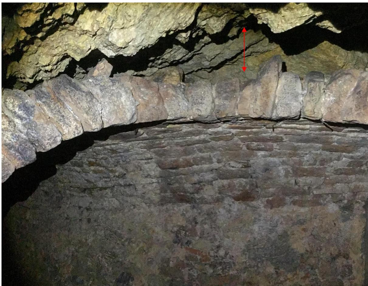
**Abbildung 9: Tiefkeller des Waldschlösschens, zwischen dem gemauerten Gewölbe und dem darüber liegenden Naturstein befindet sich ein großflächiger Hohlraum mit einer geschätzten Durchschnittshöhe von 5 cm**
