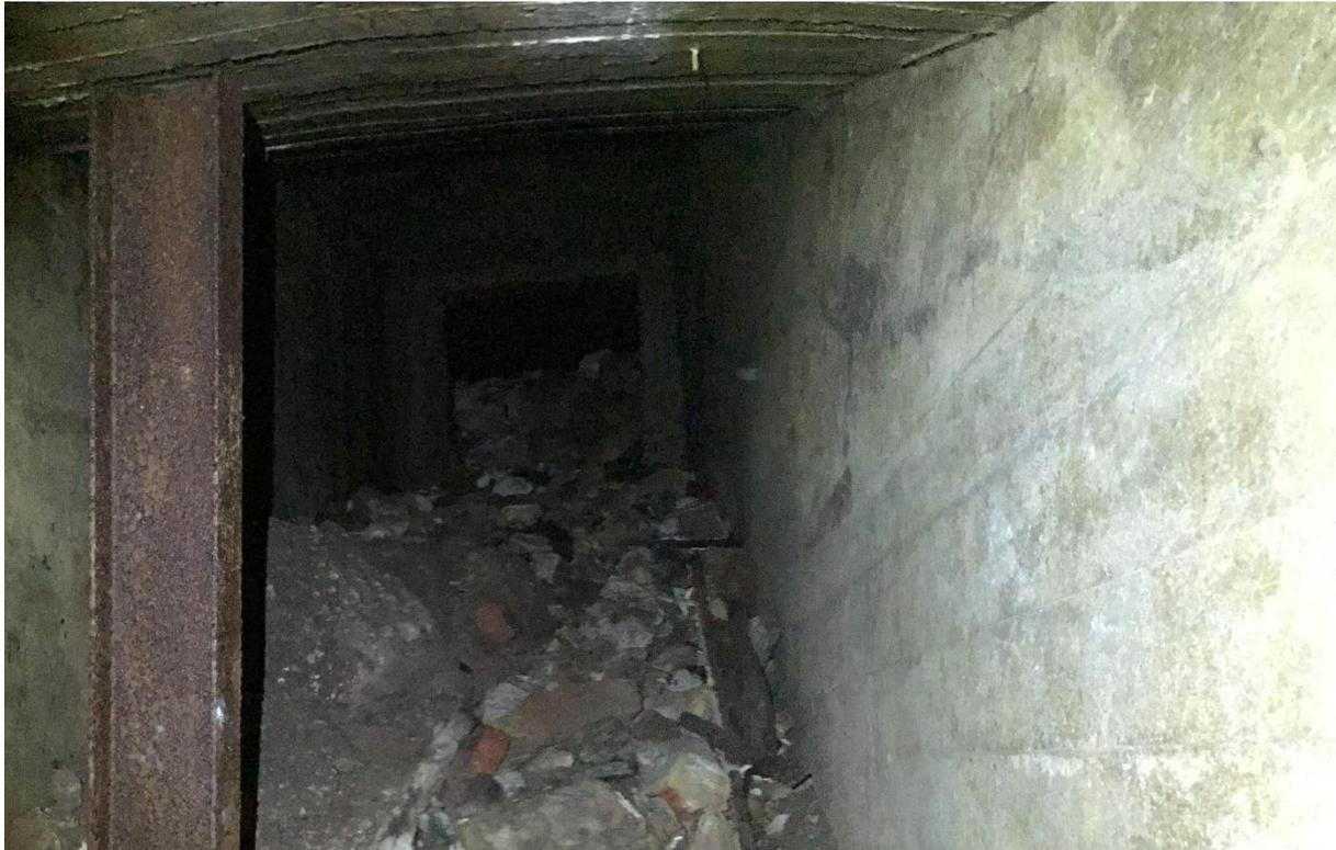
**Abbildung 12: Tiefkeller des Waldschlösschens, derzeit verschütteter Zugang = Öffnungsmöglichkeit 2**
