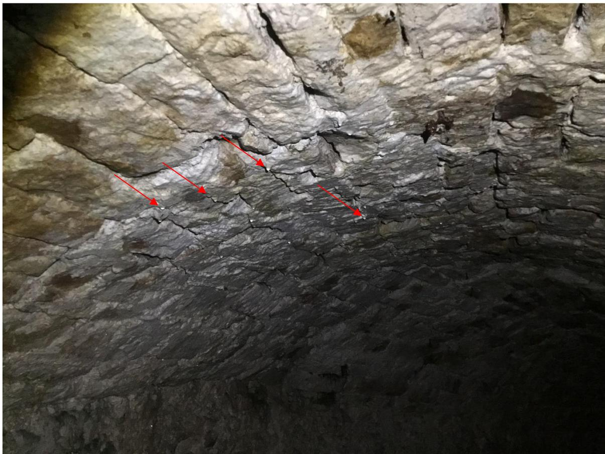
**Abbildung 10: Tiefkeller des Waldschlösschens mit Wasseraustritt, die Pfeile markieren nur exemplarisch einige der vermehrt an dieser Stelle austretenden Wassertropfen**
