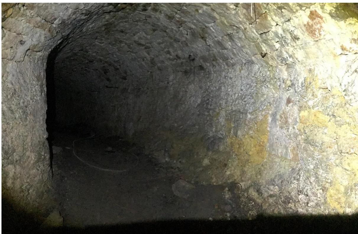
**Abbildung 7: Tiefkeller des Waldschlösschens, etwa 50 % des Gangsystems sind mit Steinen ausgemauert**
