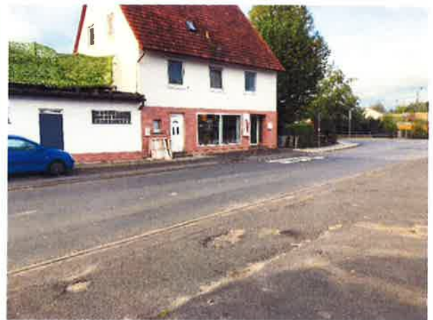
Am Engelbach Richtung Bronnzeller Str.: Übergang zwischen Haus 2 und Bürgerhaus
