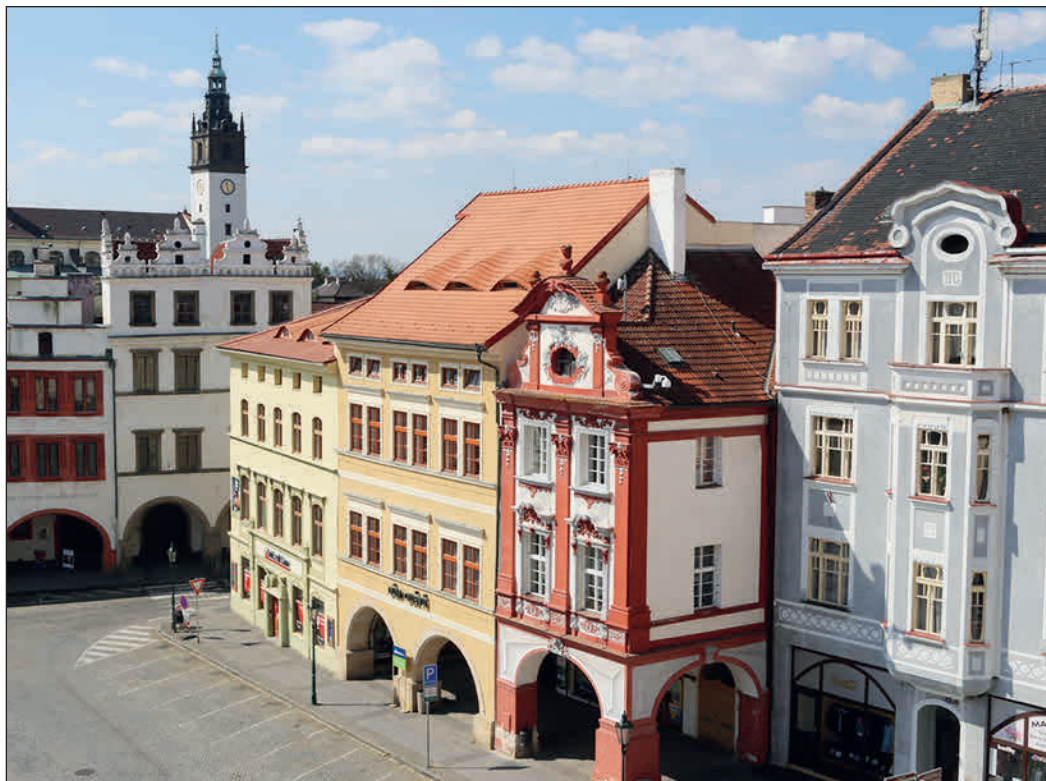
Das Stadtzentrum von Leitmeritz steht seit 1978 unter Denkmalschutz. Foto: Stadt Litoměřice
