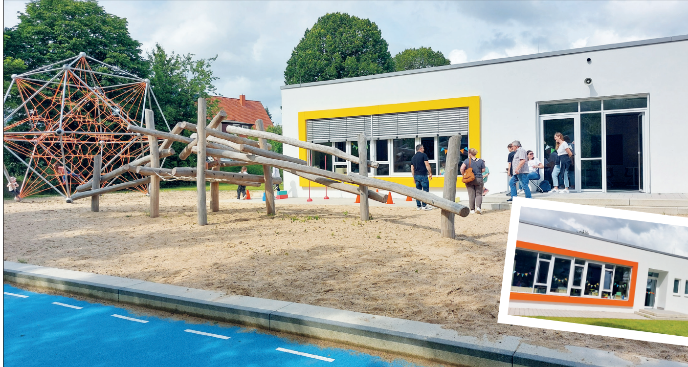
Auch das Außengelände rund um die Grundschule wurde komplett neu gestaltet. Allein hierfür investierte die Stadt Fulda mehr als eine Million Euro. Insgesamt flossen gut 4,4 Millionen Euro in das Projekt. Fotos: Grundschule Haimbach
