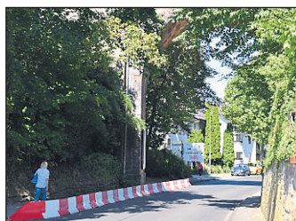
Die Bahnbrücke über den Horaser Weg. Foto: Stadt Fulda
