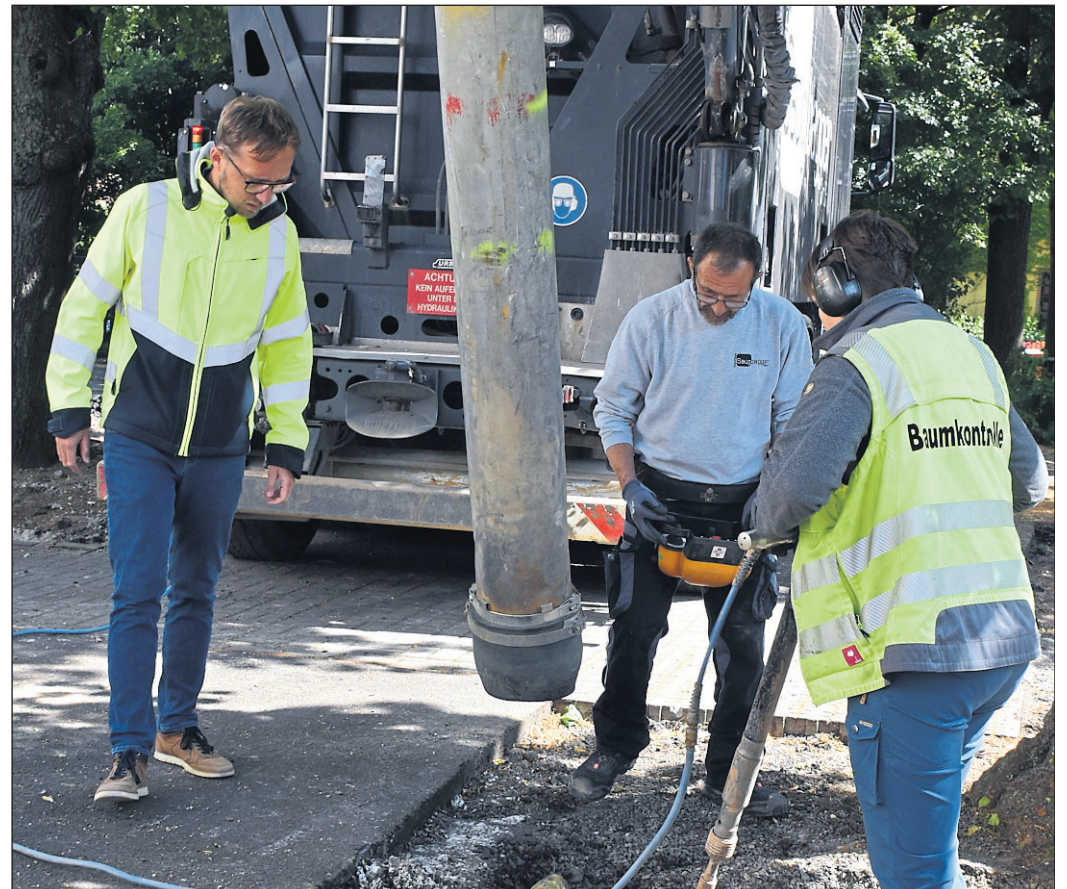
Christian Leinweber (links) und die Sachverständige Claudia Hodel (rechts) begutachten die Arbeit des Saugbaggers, der Kies und Erde aufsaugt und die feinen Baumwurzeln unversehrt lässt. Foto: Stadt Fulda
