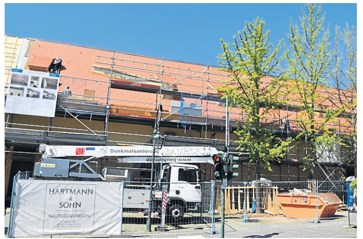
Der Gebäudeteil über der Stadtwache wurde mit neuen Biberschwanzziegeln eingedeckt. Foto: Stadt Fulda
