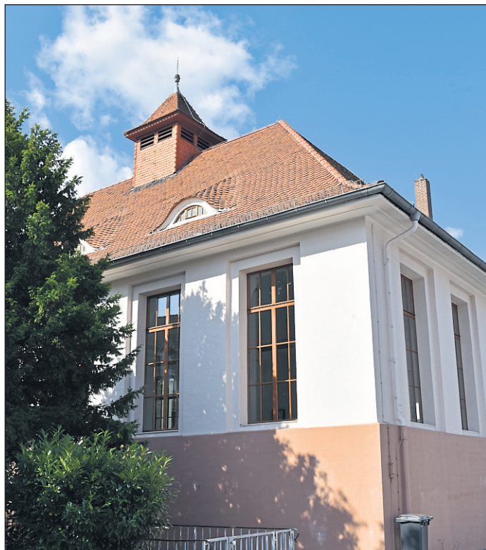
Unter anderem in der Domschule (hier die alte Turnhalle) fand in der ersten Zeit der Unterricht statt.
