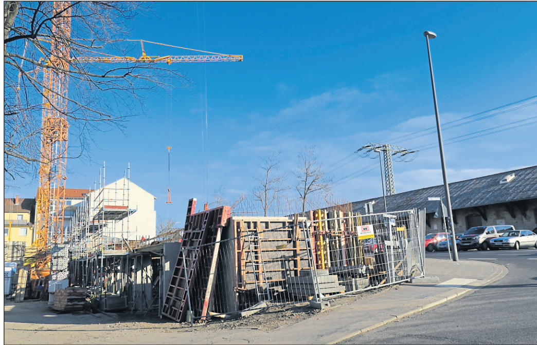
Das aktuelle Projekt der GWH-Bauprojekte GmbH am Bahnhof/Ecke Am Schützenhaus wird noch über das alte städtische Förderprogramm für den Sozialwohnungsbau gefördert. Inzwischen wurden die Konditionen für Bauherren noch einmal verbessert. Fotos: Stadt Fulda
