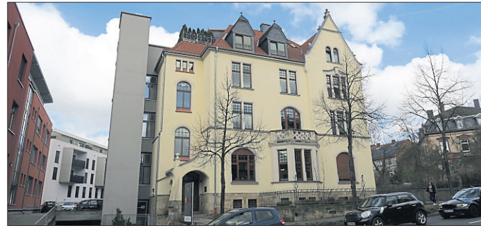
Das ehemalige Rabbinerwohnhaus in der Von-Schildeck-Straße.
