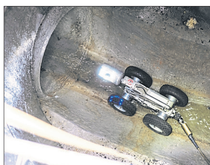
Mit speziellen Kanalkameras werden die Leitungen befahren (links), per Monitor (rechts) lassen sich die Schäden begutachten.
