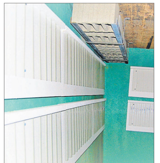
Hohlblocksteine und Spezialkästen aus Kunststoff haben dazu beigetragen, dass der ehemalige Hochbehälter von den Tieren als Überwinterungsquartier angenommen wurde.
