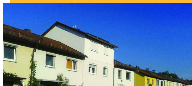
Abb. 125: Referenz zur Aufstockung von Reihenhäusern in Marbach/Neckar
