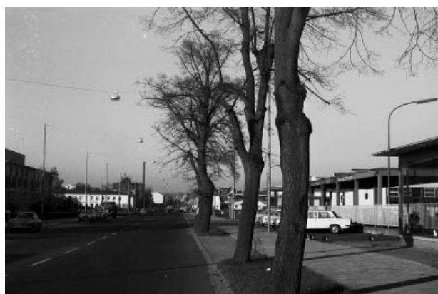
Abb. 8: Frankfurter Str. nach dem Umbau 1971
