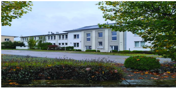
Abb. 103: Blick auf das ehemalige Teknos-Verwaltungsgebäude
