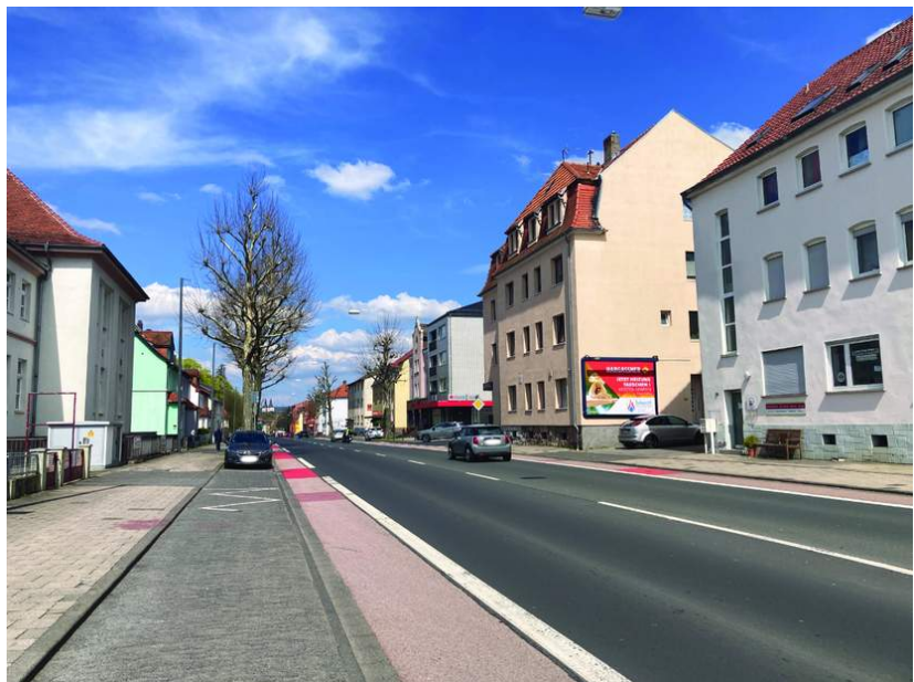
Abb. 72: Hauptverkehrsstraße Frankfurt Straße
