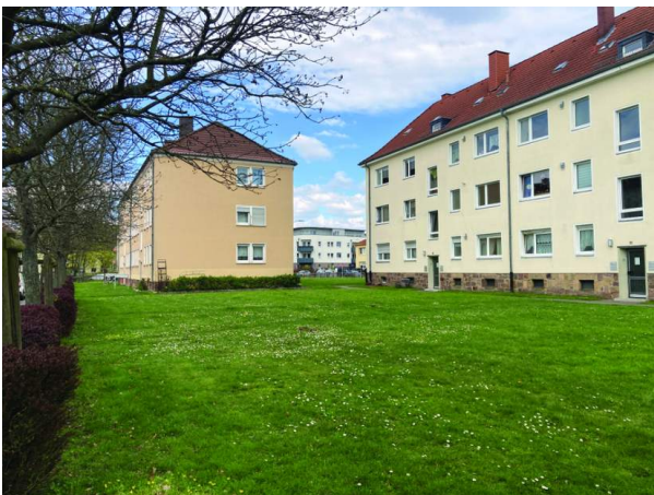
Abb. 62: Wohnanlage Nassauische Heimstätte
