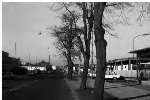
Abb. 8: Frankfurter Str. nach dem Umbau 1971
