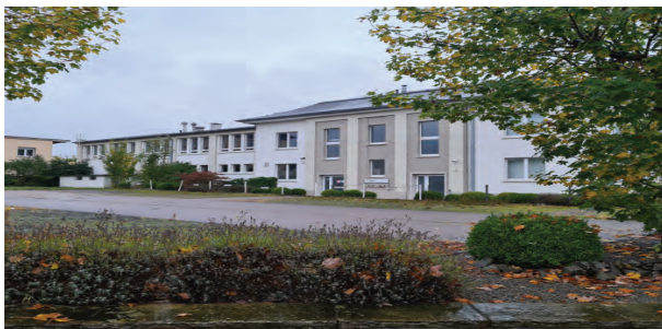
Abb. 103: Blick auf das ehemalige Teknos-Verwaltungsgebäude
