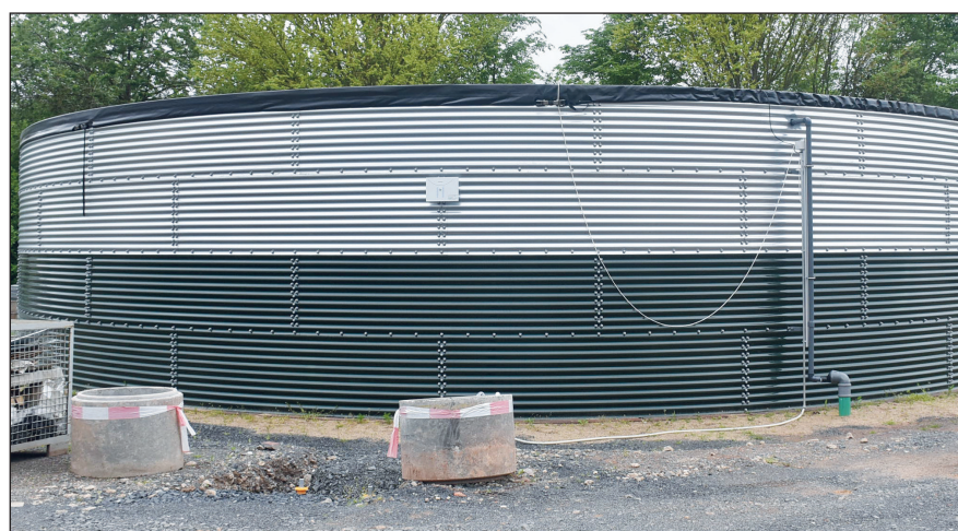
In diesem Tank können 500 Kubikmeter Regenwasser zum Gießen gelagert werden – damit wurden die bisherigen Kapazitäten mehr als verdoppelt.
