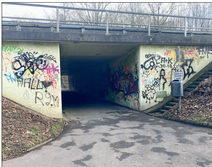
Die B27-Unterführungen im Nordend werden oft als unsichere Orte wahrgenommen. Mehr Licht und eine neue farbliche Gestaltung sollen Abhilfe schaffen. Foto: Stadt Fulda
