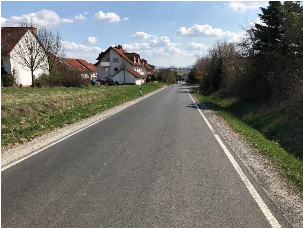
Abbildung 3.10: Nördlicher Bereich der Fuchsstraße ohne Gehwege.
