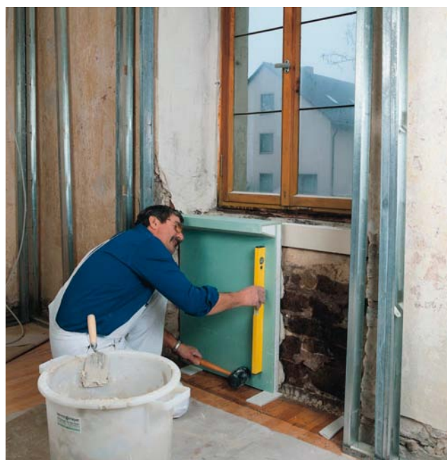
Verbundplatte aus Gipskarton und Dämmung mit Formteil zur Montage der Fensterbank
