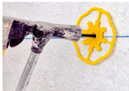
Ankerdübel als Halt für den Dämmstoffkleber direkt auf dem alten Putz
