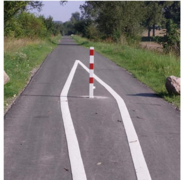
Abbildung 1: Warnmarkierung eines Sperrpfostens
