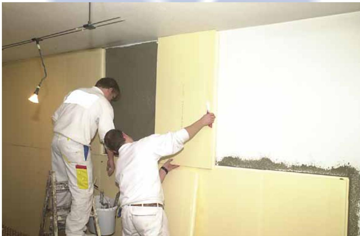
*Innendämmung mit Dämmplatten.*
