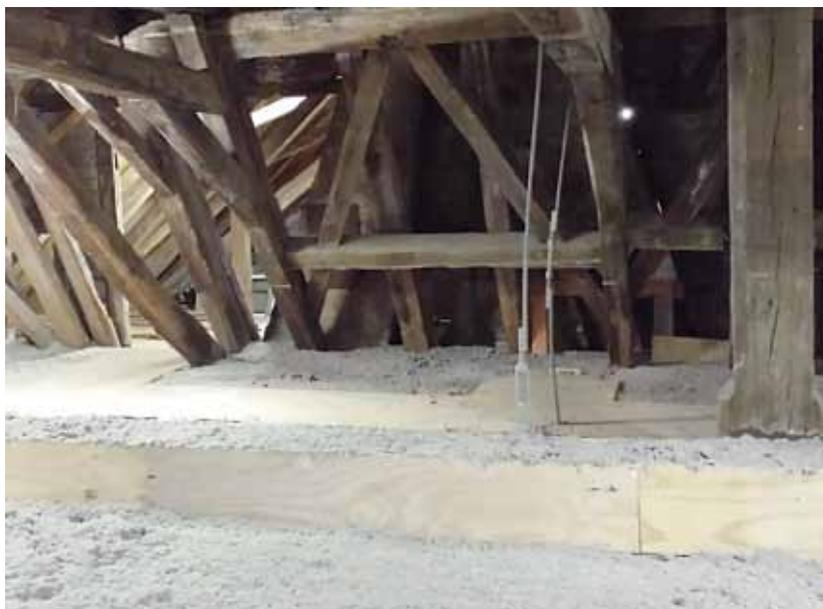
Dämmung der obersten Geschossdecke mit Zelluloseflocken.
