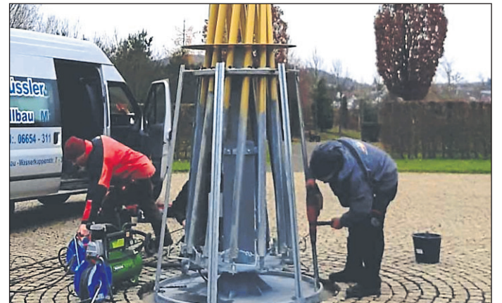
Mitarbeiter der Firma Schüssler aus Gersfeld haben den Turm installiert und in der Erde verankert. Foto: Büro Trapp/Wagner
