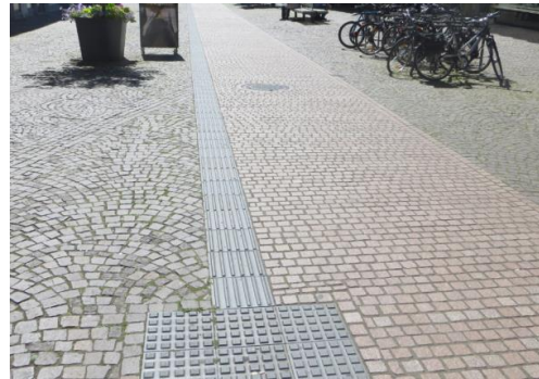
Abbildung 98: Integration taktiler Leitelemente in der Marktstraße
