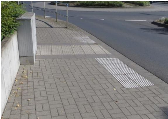
Abbildung 103 & 104: Taktile Leitelemente entlang der Rangstraße
