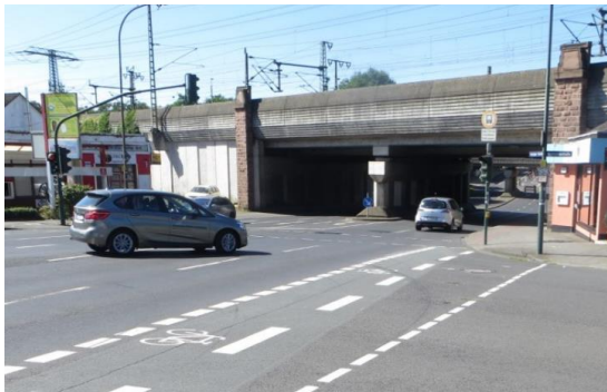
Abbildung 114: Bahnunterführung Leipziger Straße
