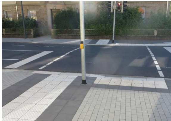
Abbildung 103 & 104: Taktile Leitelemente entlang der Rangstraße
