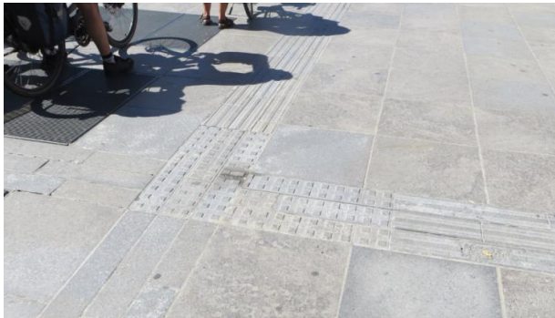
Abbildung 97: Taktile Leitelemente auf dem Universitätsplatz
